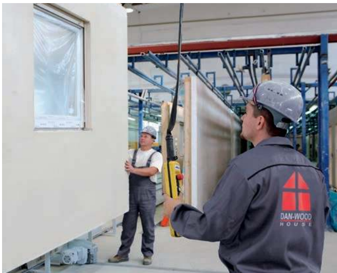
Die Wände werden in der Fabrik vorgefertigt...
