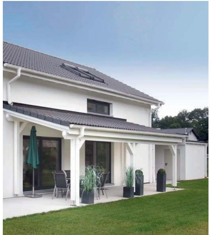
Solides Dach über der Terrasse
