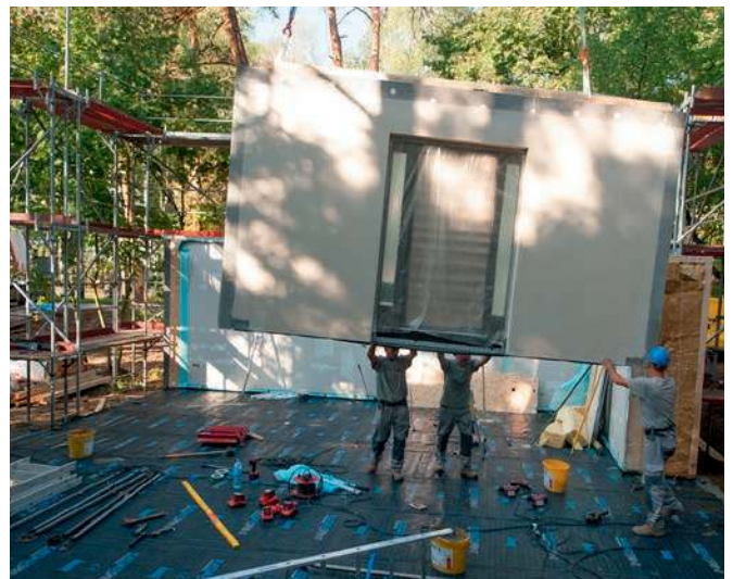
... auf LKW zum Bauplatz transportiert...
