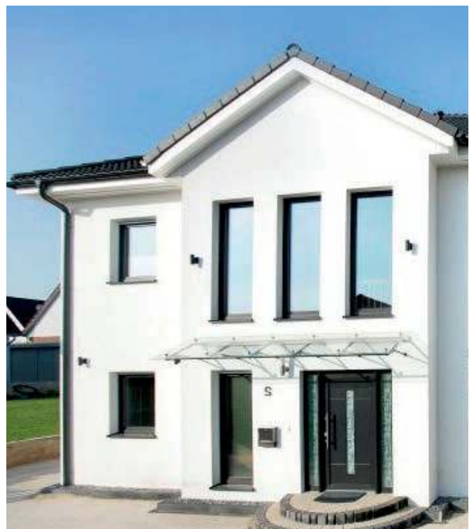
Leicht und modern wirkt eine Haustürüberdachung aus Stahl und Glas (100 x 160, 100 x 260, 100 x 125)
