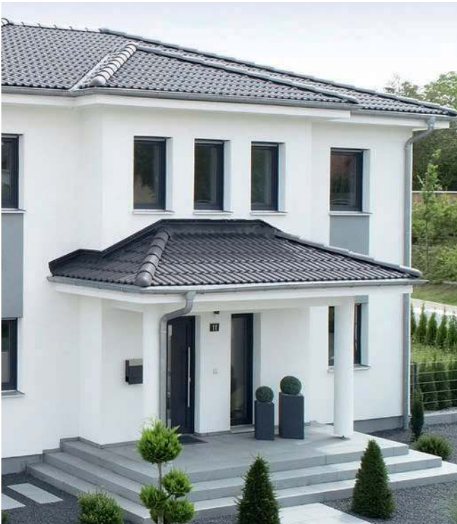
Auf eleganten Säulen ruht das ebenfalls großzügige Walm-Vordach.
