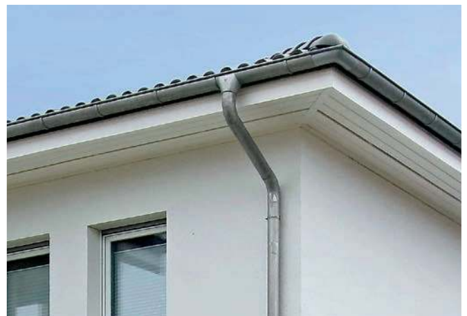
Die Unterseite des Dachüberstandes kann farbig oder in weiß (Standard) ausgeführt werden.
